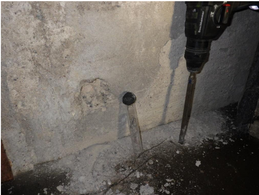
Kuva 7 Betonin kosteusmittausta [B1]
