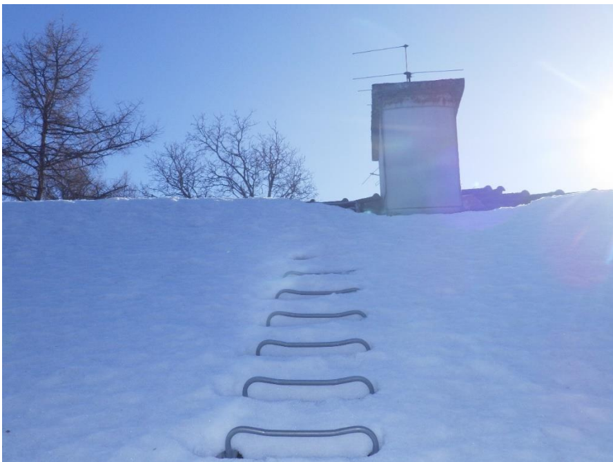
Kuva 31 Tutkimushetkellä vesikatolla lumipeite
