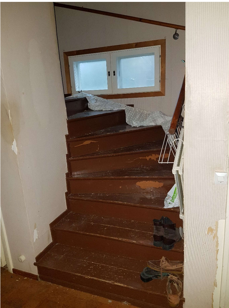
Kuva 6. Sisäportaiden ruskea maali ylittää raskasmetalleille asetettuja ohjearvoja.
