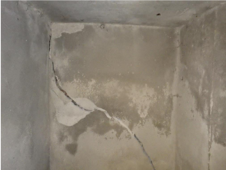
Kuva 6 Perusmuurin runkohalkeamia
