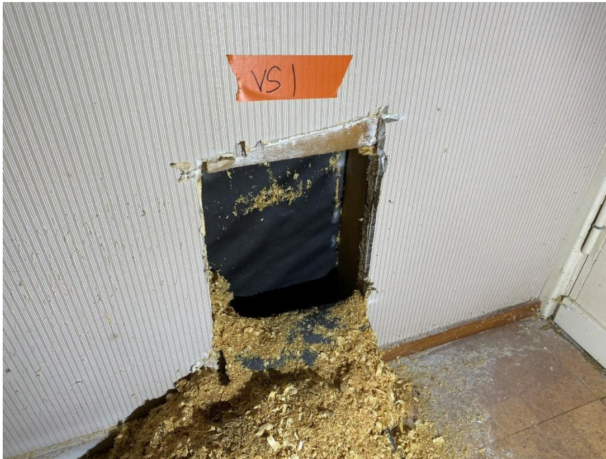
Kuva 23 Väliseinän rakenneavaus [VS1]
