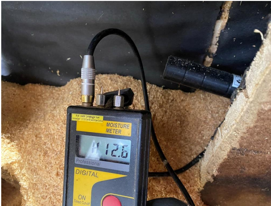
Kuva 25 Kosteusmittausta väliseinän runkorakenteista [VS3]
