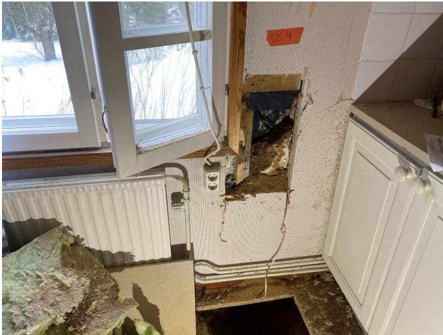
Kuva 13 Ikkunaliitoksen toteutustapaa [US4]
