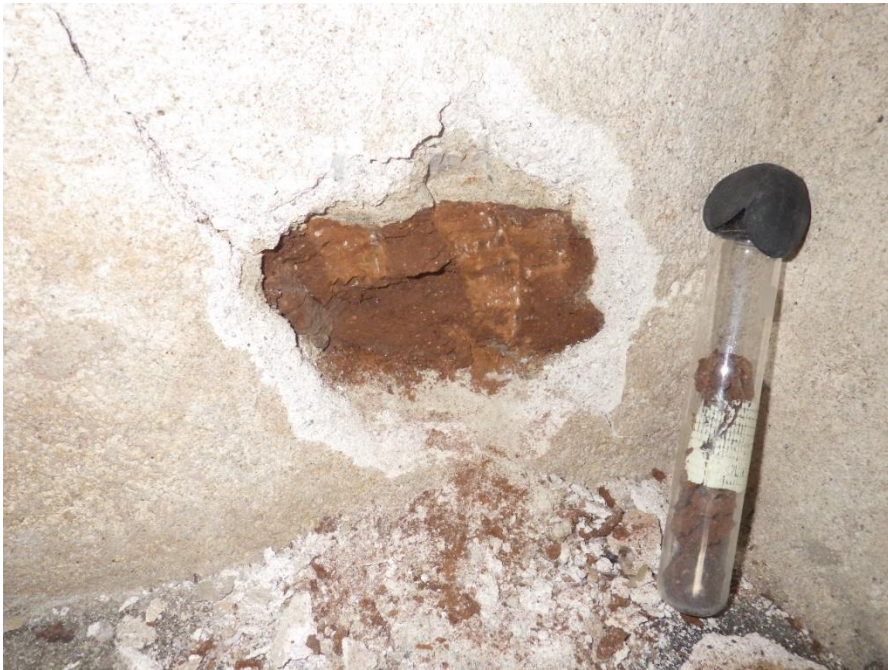
Kuva 8 Kellarin runkorakenteiden kosteusmittausta [B2]
