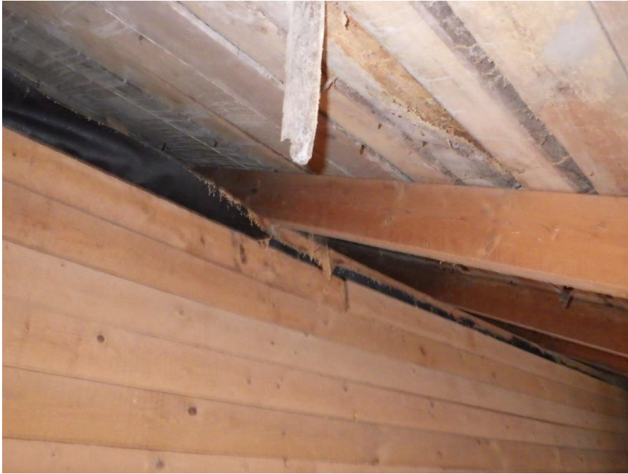
Kuva 28 Vesikaton vinon osuuden tuuletusta
