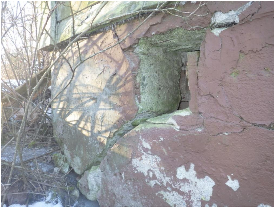
Kuva 4 Perusmuurin runkohalkeamia
