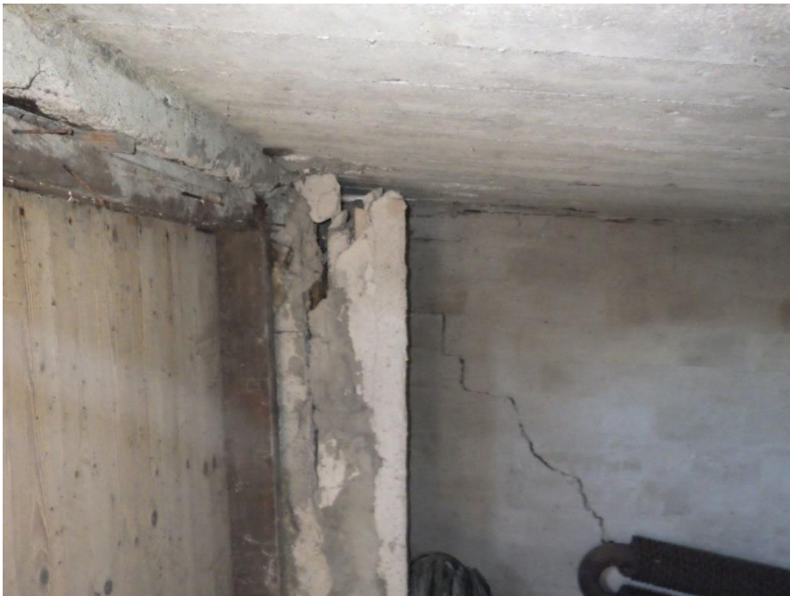
Kuva 5 Perusmuurin runkohalkeamia
