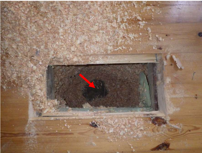
Kuva 5. Alapohjalaatan yläpinnassa olevan bitumisivelyn PAH-summapitoisuus ylittää vaarallisen jätteen raja-arvon. Kuva on olohuoneen lattiarakenteesta.
