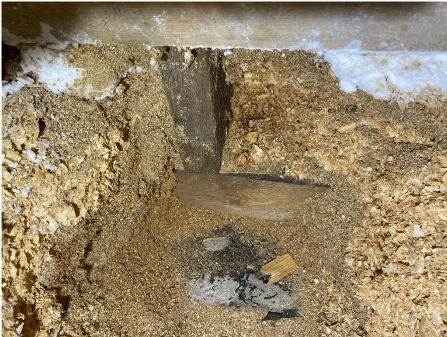
Kuva 15 Ulkoseinän alaosan rakenteita välipohjan sisällä [US4]
