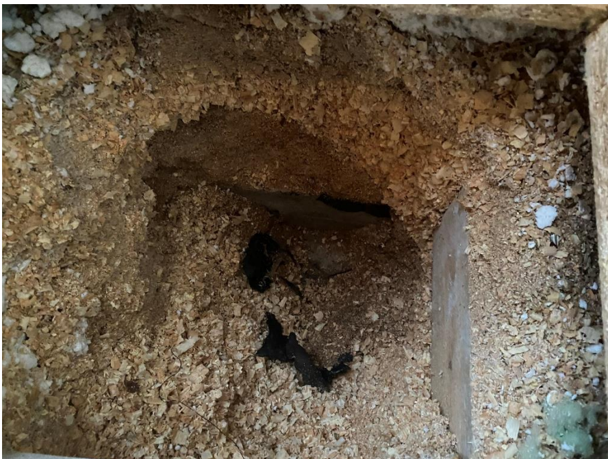
Kuva 3 Alapohjarakennetta ensimmäisessä kerroksessa [AP2/VP3]
