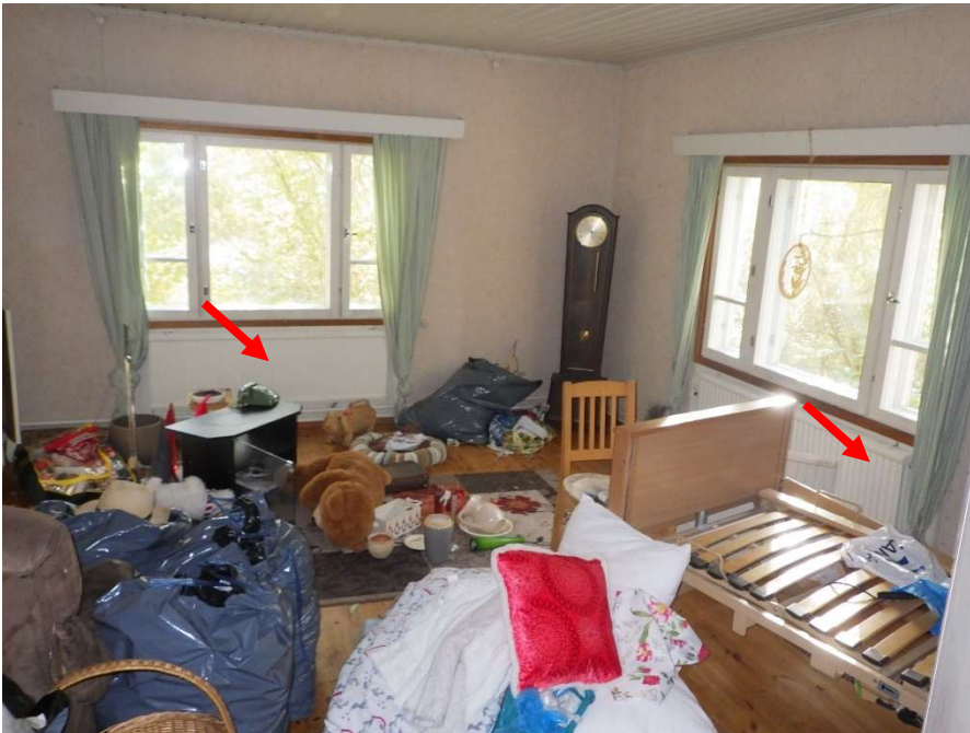
Kuva 13. Lämmityspatterien maali sisältää todennäköisesti ohjearvot ylittävän määrän raskasmalleja (epähuomiossa ei otettu näytettä).
