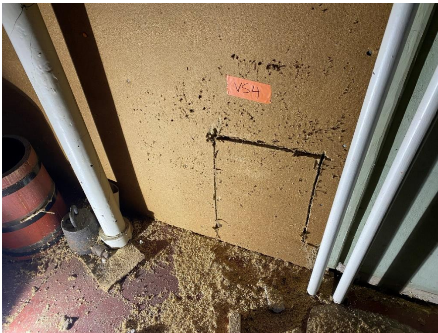
Kuva 26 Väliseinän tutkimuspiste 2. krs, piipun vieressä. Ei viitteitä vauriosta.
