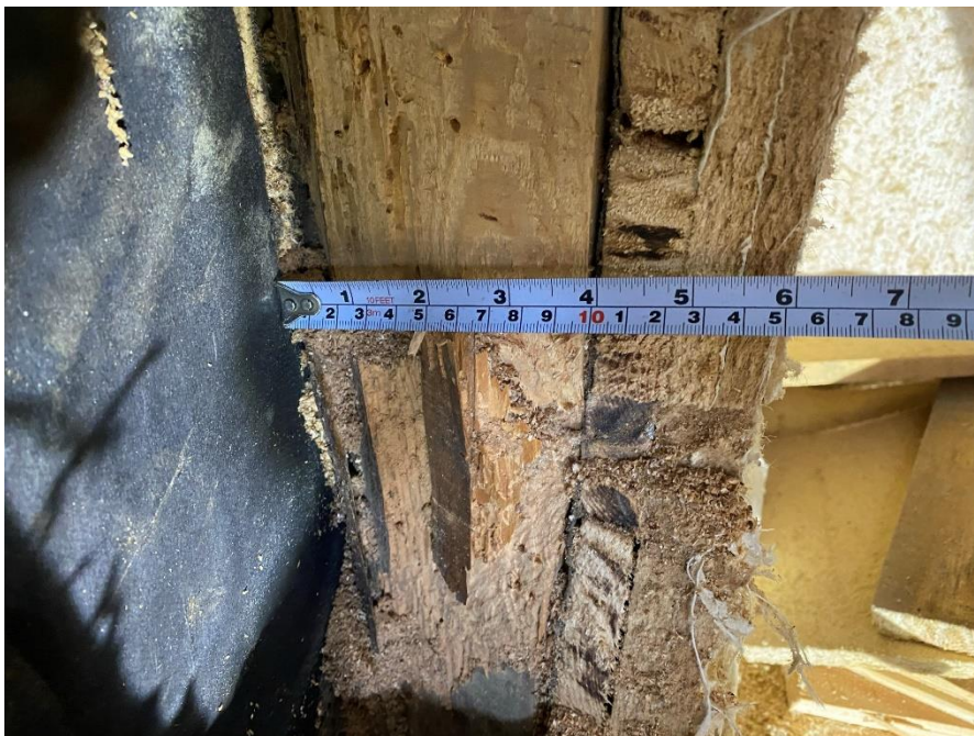
Kuva 14 Ulkoseinän rakennekerroksia [US2]
