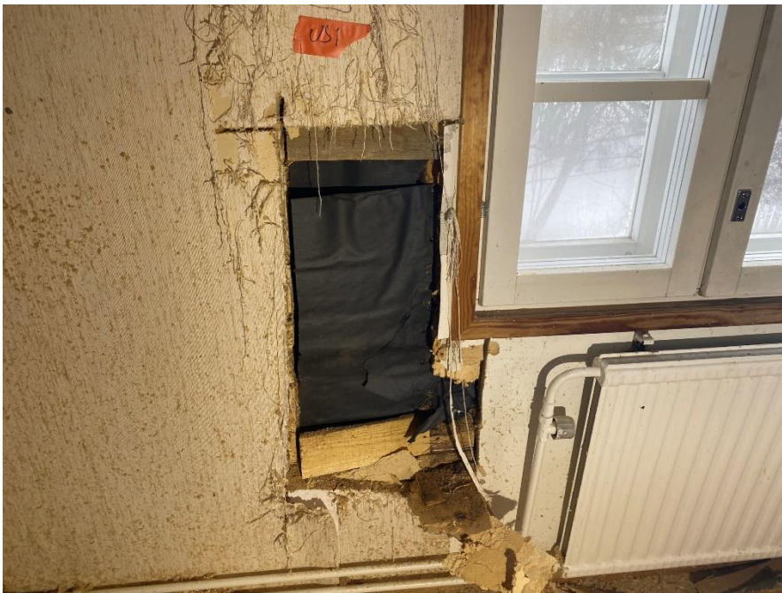
Kuva 10 Ulkoseinän rakenneavausta [US1]
