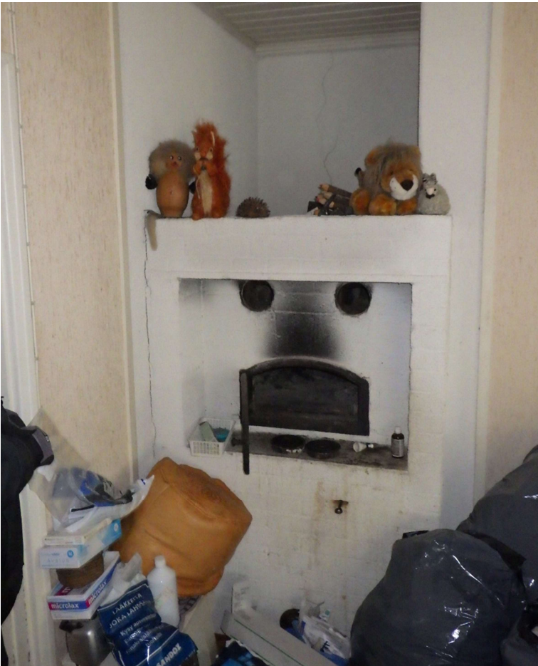
Kuva 11. Tuvan leivinuuni. Ohjeiden mukaan etenkin 1940-60 luvuilla erilaisissa uuneissa (saunan-, leivin- ja rikkauunit) käytettiin lähinnä asbestipahvia palonsuojaukseen. Uunin pintarakenteiden sisällä saattaa olla asbestipitoista pahvia. Uunista otettiin näyte vain sen pintavalusta. Pintavalu ei sisällä asbestia.
