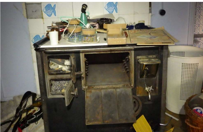
Kuva 12. Yläkerran hella. Ohjeiden mukaan etenkin 1940-60 luvuilla erilaisissa uuneissa (saunan-, leivin- ja rikkauunit) käytettiin lähinnä asbestipahvia palonsuojaukseen. Uunin pintarakenteiden sisällä saattaa olla asbestipitoista pahvia (ei näytettä).
