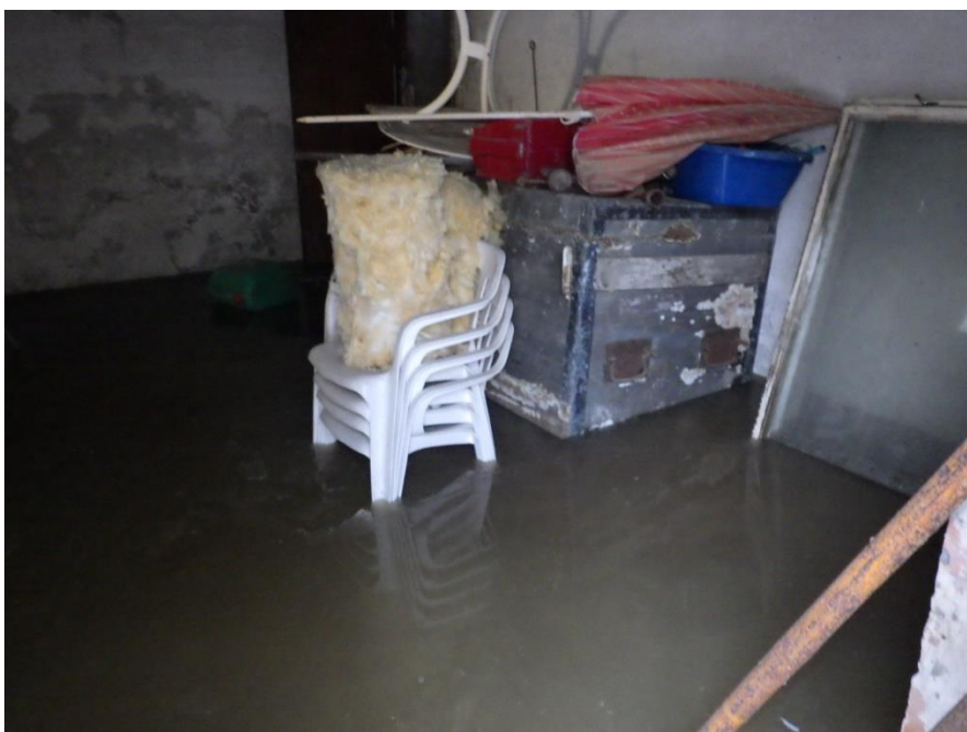
Kuva 1 Alapohjarakenne kellaritilassa veden peitossa
